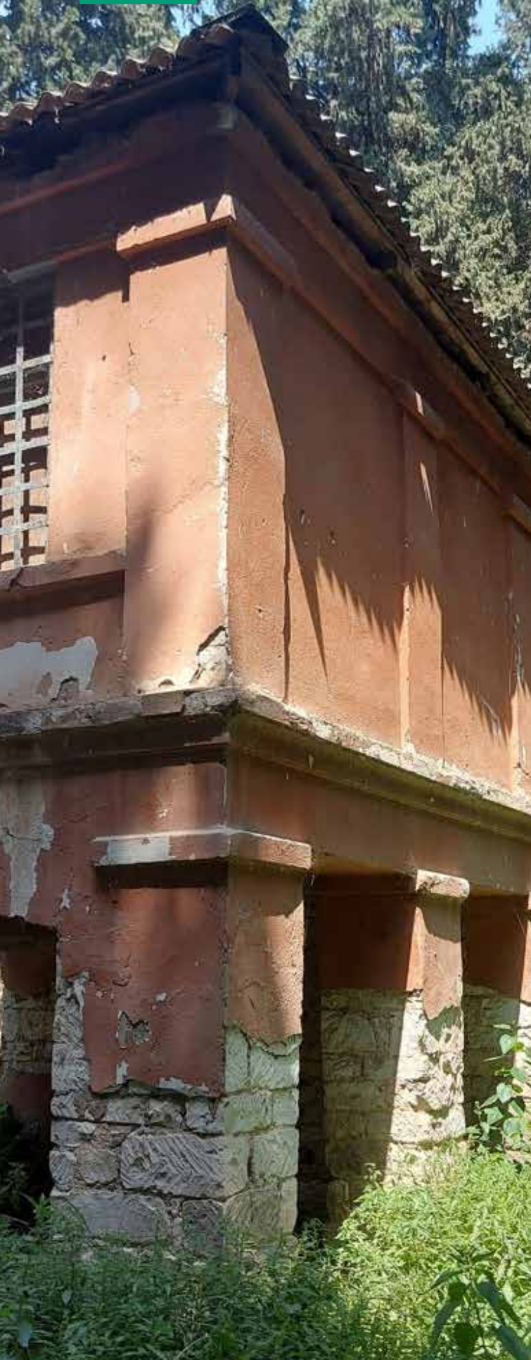
Projektor. Rückfassade. Foto der Autorin. 2023
