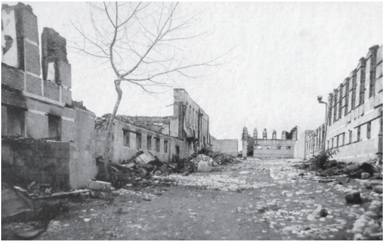
Zerstörte Häuser auf der Shihminasskoy Straße (Foto AUK)
