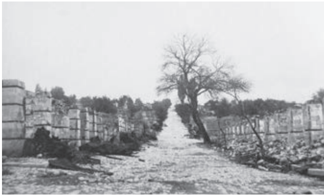
Der Blick auf die Gyurdzhibazarnoy Straße (Foto AUK)
