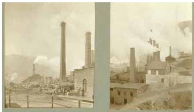
Siemens' Bergwerk in Kedabeg
