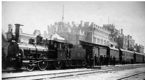
Пассажирский поезд на Бакинском вокзале. 1900 г.
