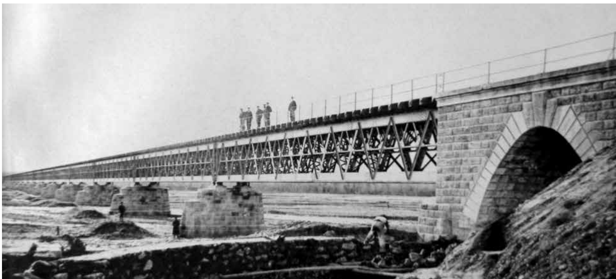
Железнодорожный мост через р. Самур. 1901 г. Фотография публикуется впервые
