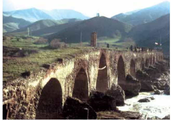
جسر جديد أو ترميم القديم.
