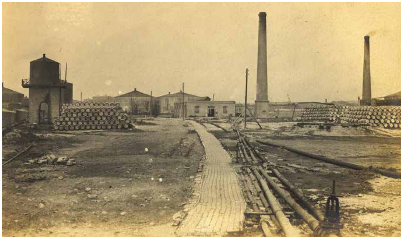
Un deposito per lo stoccaggio e trasporto del petrolio nelle vicinanze di Baku. Sono visibili le cisterne e le tubazioni utilizzate per il pompaggio del greggio. Museo Nazionale di Storia dell'Azerbaijan. Fotografia inedita
