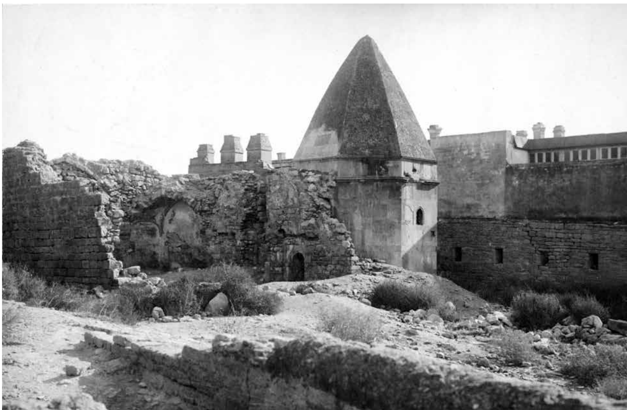
Разрушенная армянами в марте 1918 года мечеть во дворце Ширваншахов в Баку. Начало 30-х годов XX века. Фото А.Алекперова
